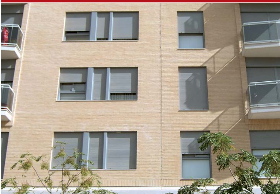
Fachada terminada y limpia. Las manchas de humedad han desaparecido.
