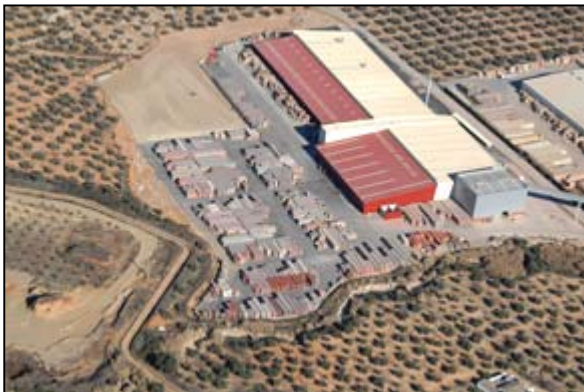
Imagen aérea de la planta M-4
